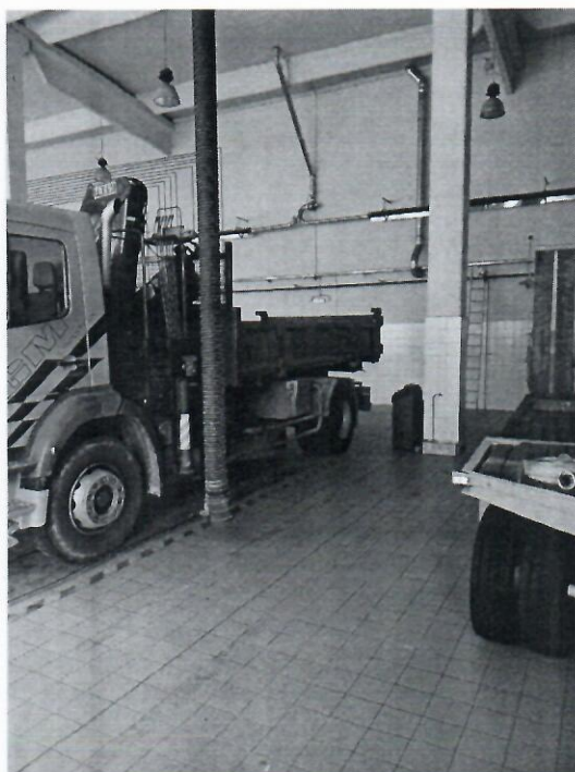
Bubnjevi s ventilatorom za odsis ispušnih plinova vozila u servisu bez spoja na odsis
